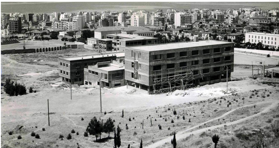
Εικόνα 2. Όψη του κτιρίου στο στάδιο της κατασκευής
